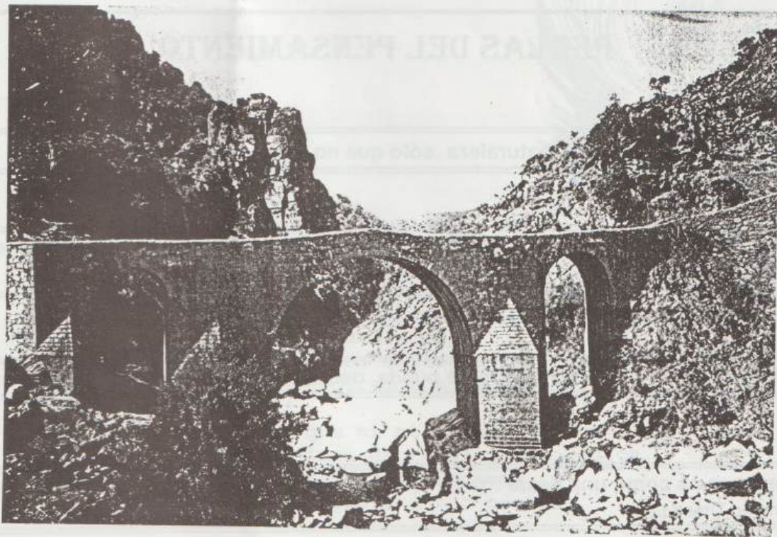
Puente para caminantes entre Puerto Seguro y San Felices. En tiempos de este memoria tenía su ojo central destruído Se pide hacer otro, aguas abajo, creo, para suministro del Fuerte.
