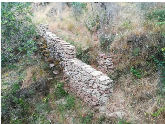
En este caso para mejorar el acceso al regato donde está situada la boca de la mina La Galache (80 m. de galería), mediante la construcción de unos escalones con barandilla de piedra, las cuales fueron recogidas de una pared situada en el entorno de la Dehesa.
