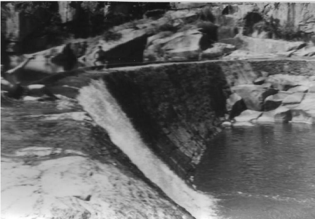
Este impresionante muro fue construido entre 1900 y 1905, fecha en la que entró en funcionamiento la minicentral de Puerto Seguro. La presa se hizo para retener el agua del río dándole salida por el Canal, de algo más de seis kilómetros de longitud. Tiene el honor de ser la central o minicentral más antigua de la provincia de Salamanca.
